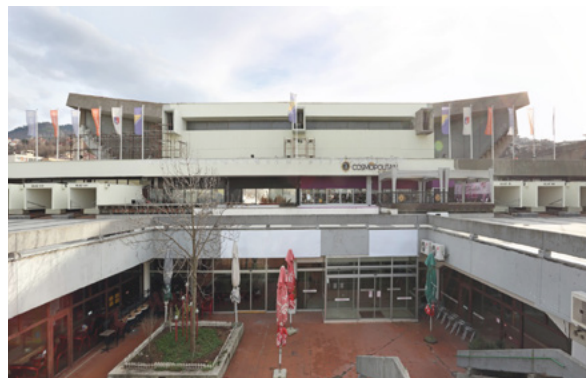
Figure 7 Skenderija - Renovation process. Source: Anida Krečo. Ilustracija 7 Skenderija - u procesu obnove. Izvor: Anida Krečo
